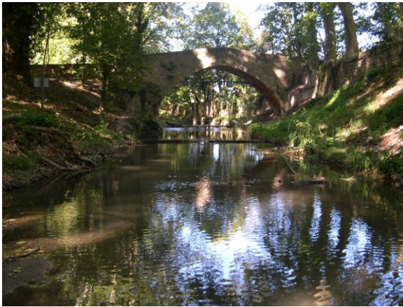
station 02 : vue générale
