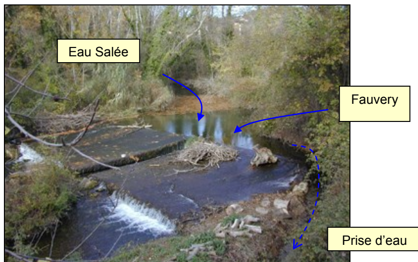
Photo n° 4 : Seuil et prise d'eau sur l'Eau Salé en aval immédiat de la confluence avec le Fauvery
