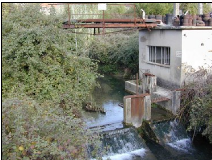
Photo n° 3 : Ecluse sur le ruisseau des Ecrevisses en amont immédiat de sa confluence.
